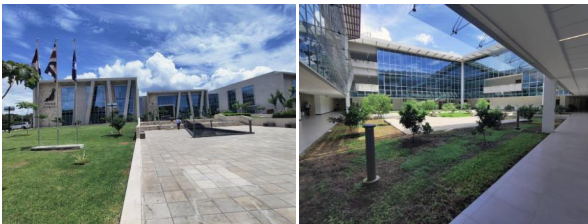
Fotos: Vista general del edificio de los Tribunales de Justicia de Puntarenas.
